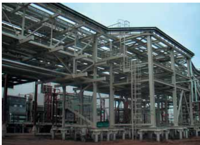
Металлоконструкции эстакады для трубопроводов Южно-Шапкинского нефтяного месторождения полиуретановая система покрытия на основе цинкнаполненной грунтовки ЦИНОТАН и эмалей ПОЛИТОН-УР
